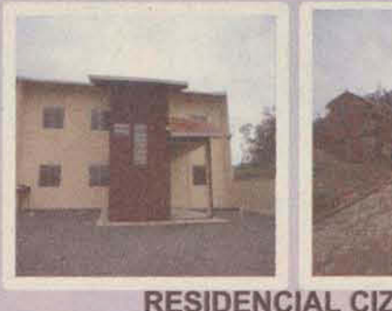
RESIDENCIAL CIZESKI Apartamento novo, contendo 02 dormitórios, sala/cozinha conjugada, área de serviço, BWC e vaga de estacionamento. R$ 120.900,00
