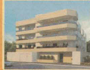
Apartamento - Vila Lalaú Edifício em construção, opção em apartamentos com 2 ou 3 dormitórios. Forma de pagamento facilitada, financiamento direto com a construtora. Apart. com 2 dormitórios a partir de R$ 120.900,00
