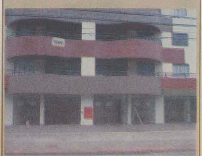
Sala Comercial com 50 mts Bairro Vila Nova ao lado Posto Mima Valor a consultar
