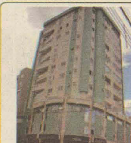
Ref. 1014 - Centro - Ed. Ruth Braun - Apto com suite + 1 quarto, móveis sob medida na cozinha e banheiros, excelente localização. R$230.000,00.
