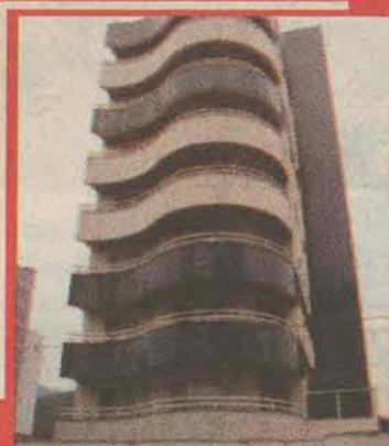
3077 - CENTRO - ED. JADE - Suite master, 2 garagens. Único apto. no andar. R$ 425 mil
