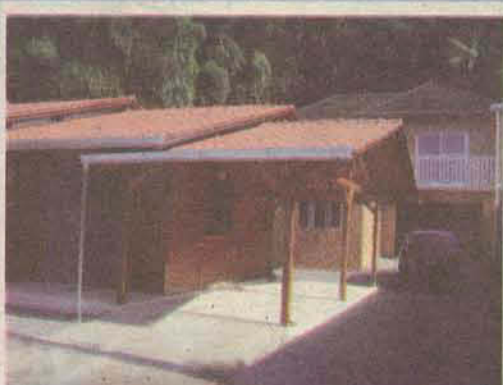
REF349 - Ana Paula - 2 casas no mesmo terreno 1 de madeira e 1 de alvenaria. R$320.000,00
