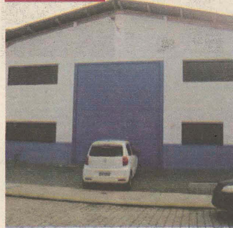
Ref. 7127 - Vila Lalau - GALPÃO COM 295M² COM BWC(MASCULINO E FEMININO) COM ESTACIONAMENTO - Área imóvel: 295,00m² - Área terreno: 420,00m² - R$ 386.000,00
