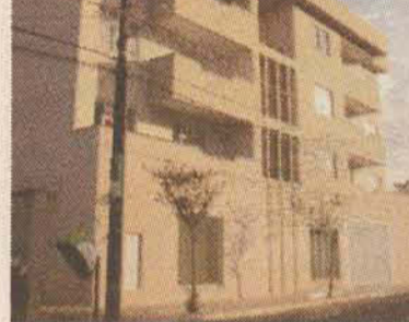
Ref. 4978 - Edifício Giuliana - 02 dorm - Área privativa: 74,96m 2 - A partir de R$165.000,00 - PRONTO PARA MORAR
