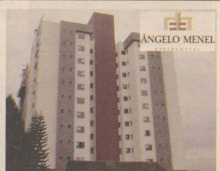
Edifício Angelo Menel, localizado na Vila Lalau.
