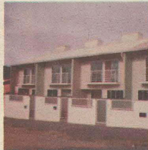
Ref 7118 - Vila Rau - 04 sobrados geminados - Área Imóvel: 170,61m² - R$250.000,00.
