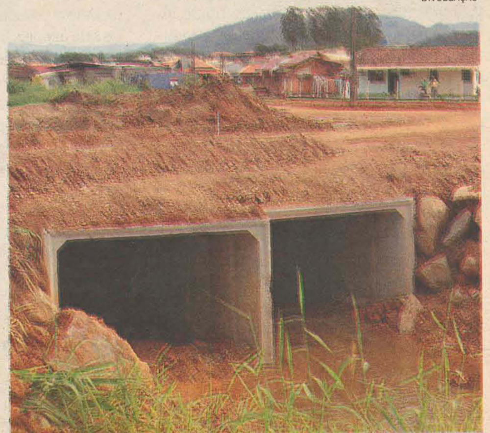
Obras ajudam a prevenir alagamentos, dando vazão à água
