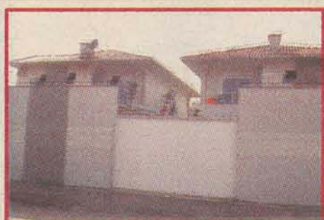
Edifício Filadélfia - Vila Lalau
