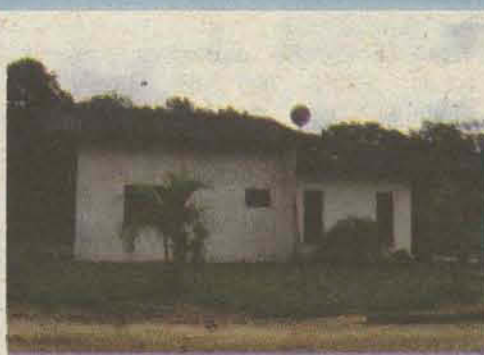
REF306 - Schroeder - Casa de alvenaria, com 2 qtos, bwc, sala e cozinha conjugadas, lavanderia e garagem. R$138.000,00
