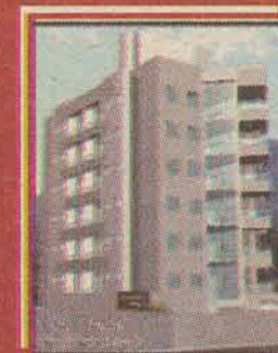
3253 - NOVA BRASILIA - APTOS em construção - Res. Málaga - c/ suite + 2 qtos. 2 vagas de garagem. A partir de R$235.000,00.
