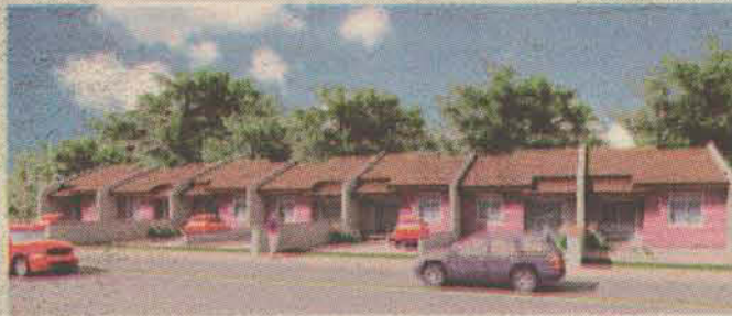
Ref 001 Lançamento para você financiar pelo Minha Casa Minha Vida: Aproveite esta oportunidade em Guaramirim no Bairro Amizade, Casas Geminadas em construção a partir de R$92.000,00
