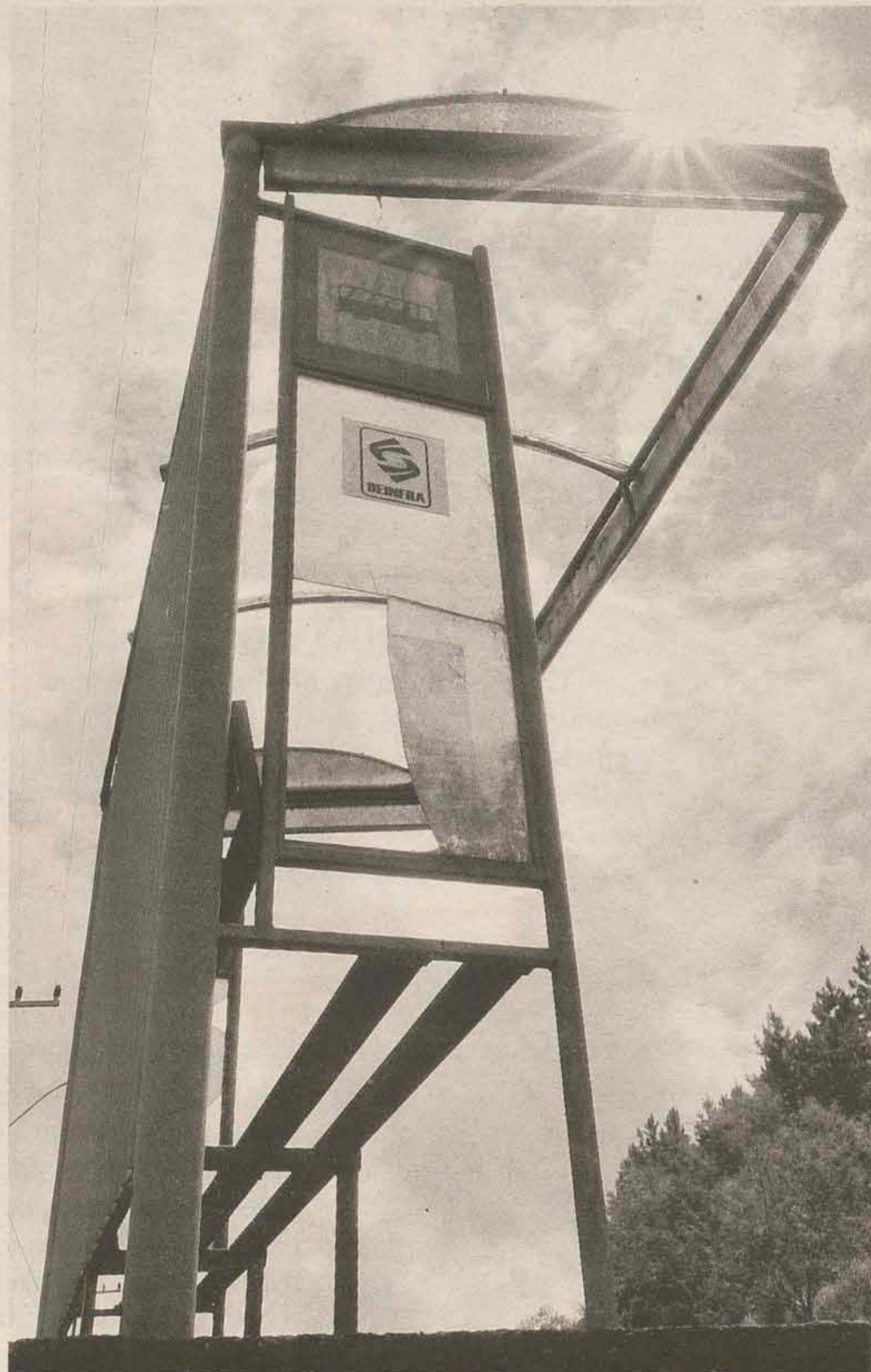
Cenário é de abandono e destruição ao longo da SC-413
