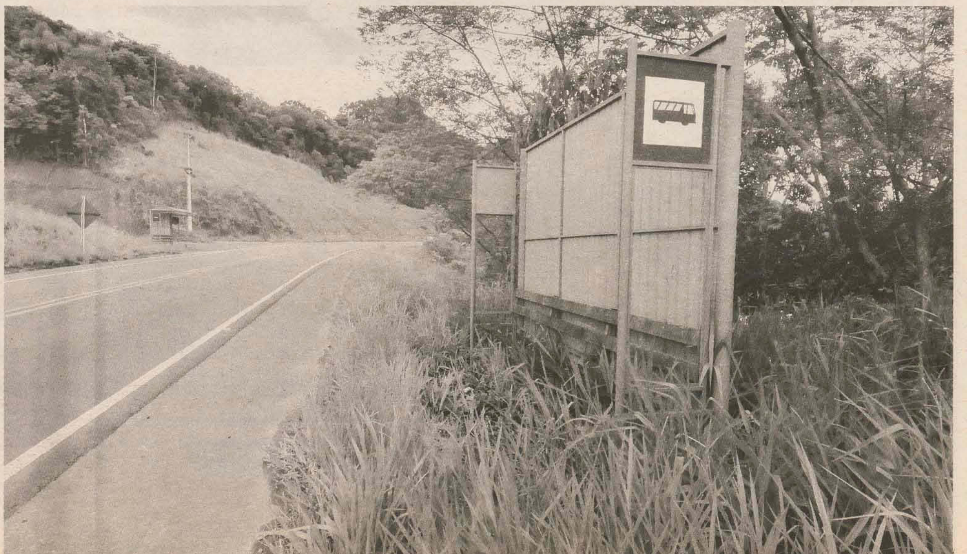
Em muitos locais, mato cobre as paradas de ônibus. De acordo com moradores, falta de manutenção já é um problema antigo
