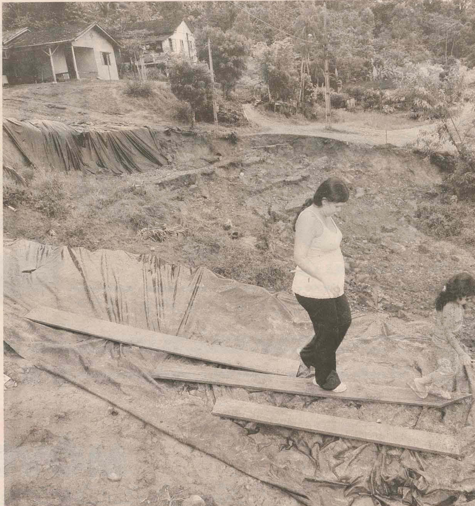
Cratera se abriu devido às enxurradas de janeiro. No local também há residências em situação de risco
