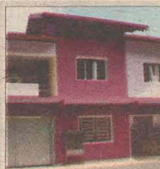
Ref 241 Vila Freitas/ Guaramirim Sobrado, térreo: com uma sala comercial, piso superior: 03 quartos, sala, cozinha, banheiro, lavanderia e varanda R$250.000,00
