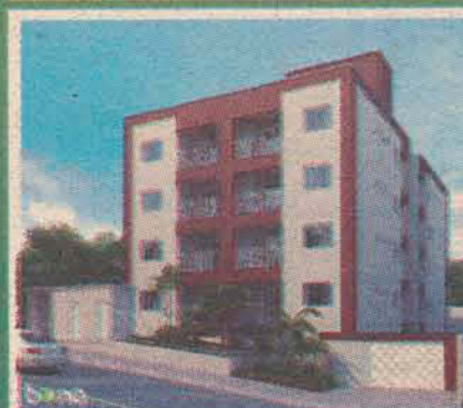
3110 - JGUÁ ESQUERDO - APTOS em construção - Res. Ana Lúcia "Torre B" - C/ suíte + 1 qto, 1 vaga de garagem. A partir de R$119.000,00 .
