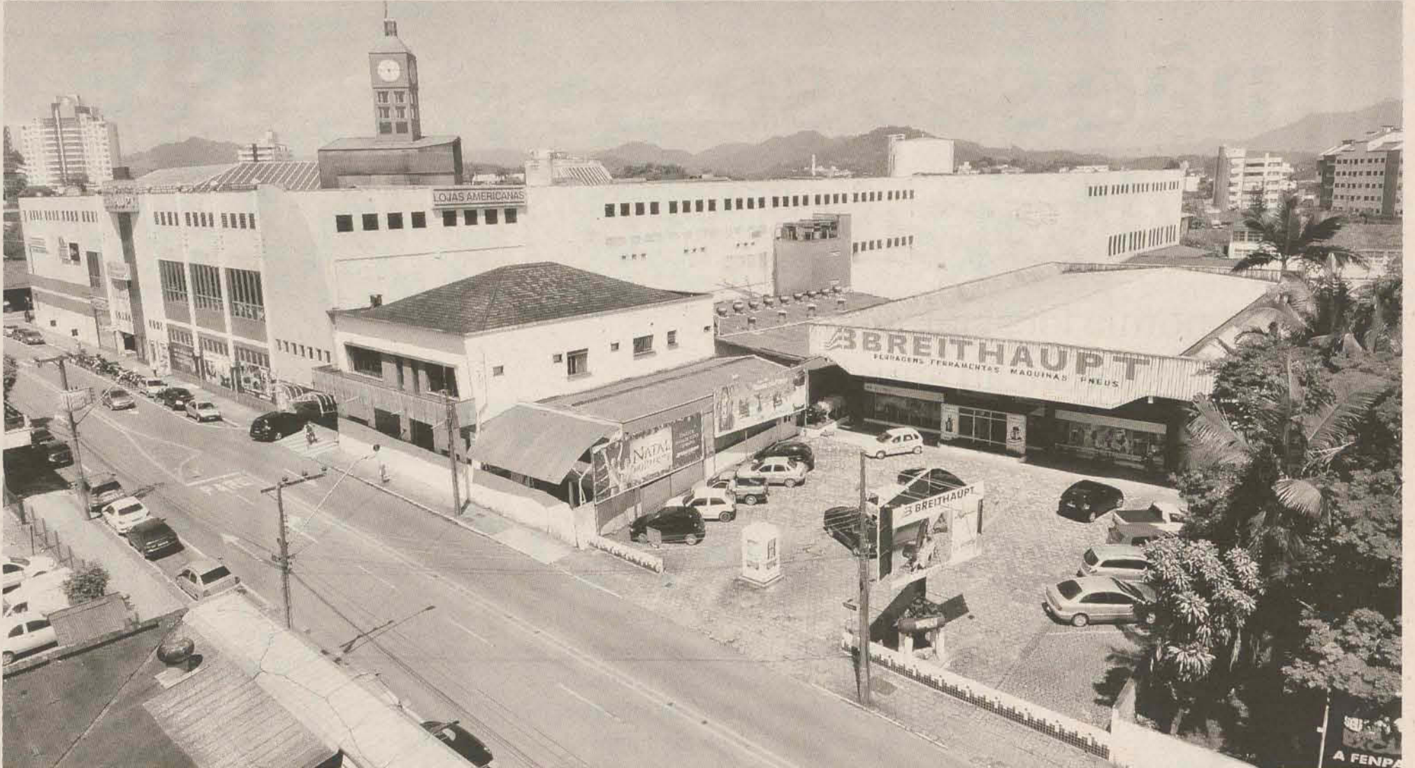
Com a obra, estrutura do shopping será duplicada, passando de 77 para 155 lojas; também há possibilidade de construção de um hotel
