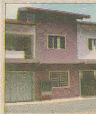
Ref 241 Vila Freitas/ Guaramirim Sobrado, térreo: com uma sala comercial, piso superior: 03 quartos, sala, cozinha, banheiro, lavanderia e varanda R$250.000,00
