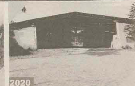
2020 Galpão aprox. 300m², terreno 567m². R. Ano Bom. Corupá. R$ 110.000,00.
