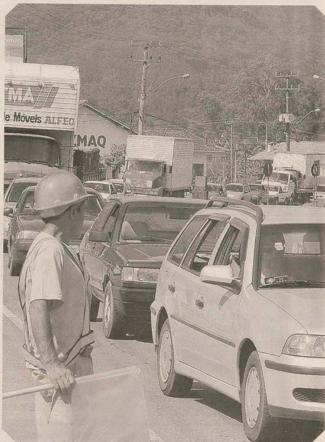
Filas na entrada e saída do município, devido obras na ponte do Portal
