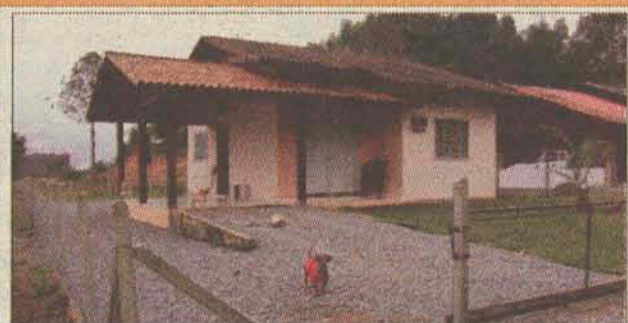
H121 casa com 77m² - 2 quartos, banheiro, sala, cozinha, lavanderia, garagem. Em Schroeder Valor: R$132.000,00.
