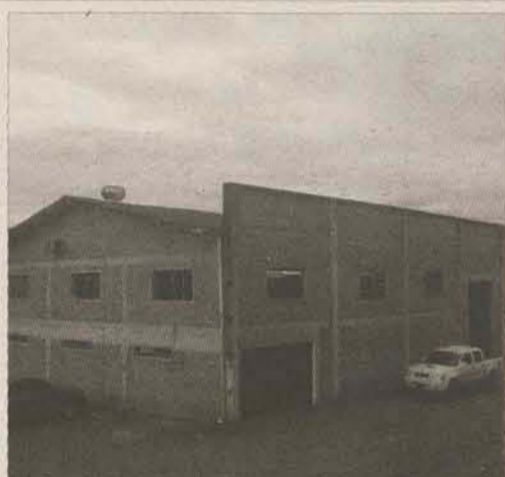
Cód 602 - GALPÃO, Bairro Santo Antonio, com 750m 2 , Terreno com 20.000m 2 , R$1.200.000,00
