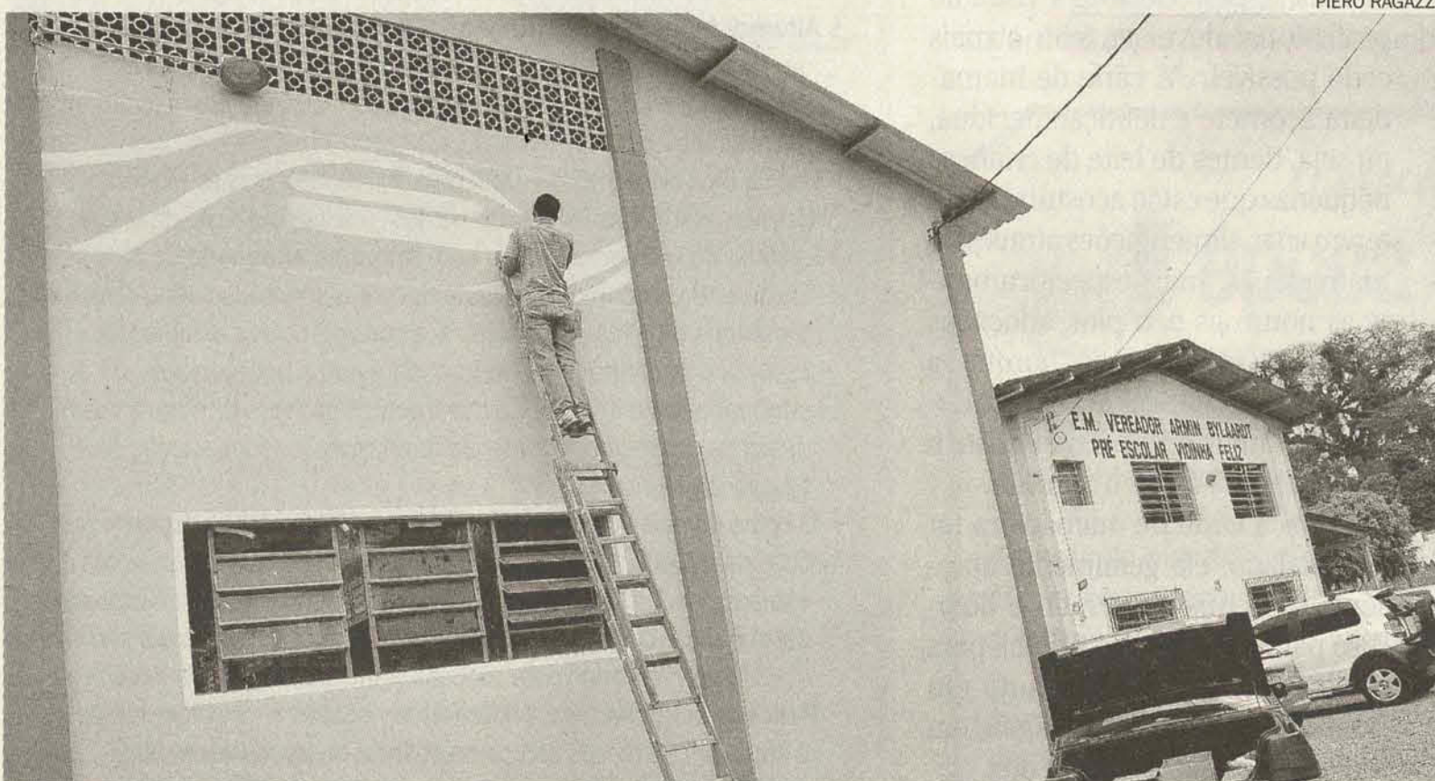
Equipe faz últimos acabamentos para inaugurar ginásio construído em 2008, mas que nunca funcionou
