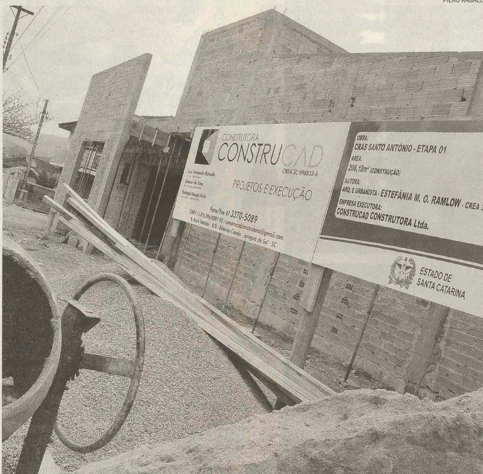
Novo Cras do bairro Santo Antônio espera pela segunda etapa de obras e deve estar pronto em novembro
