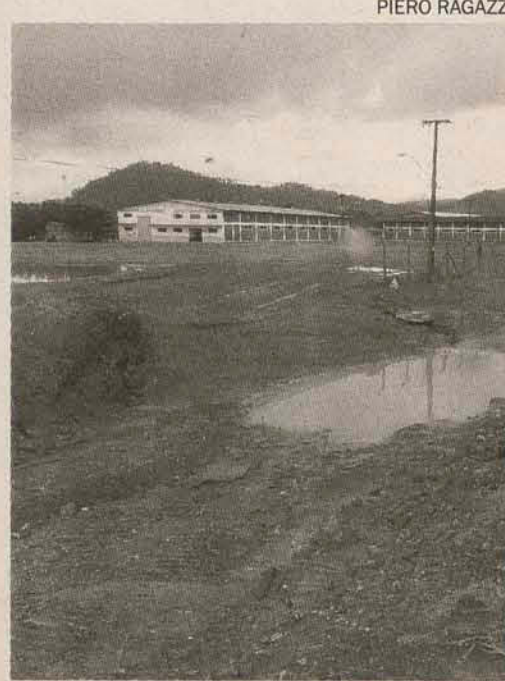
Parque de Eventos será demolido
