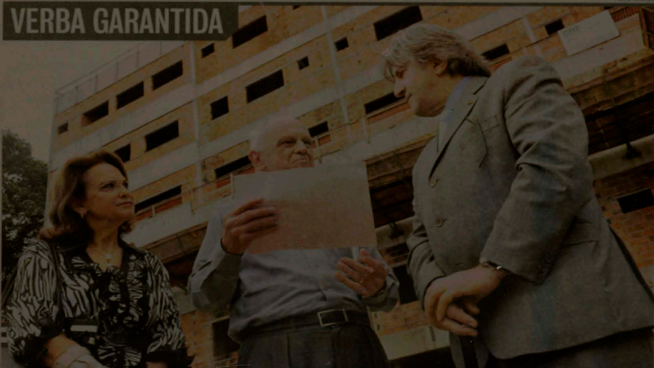
Em visita ontem ao município, o governador Leonel Pavan acompanhou os andamentos das obras de construção da unidade cardiovascular do Hospital Jaraguá e se comprometeu a liberar mais R$ 2 milhões para a entidade. Obra deve ficar pronta em 2012, com custo de R$ 26 milhões. Página 7
