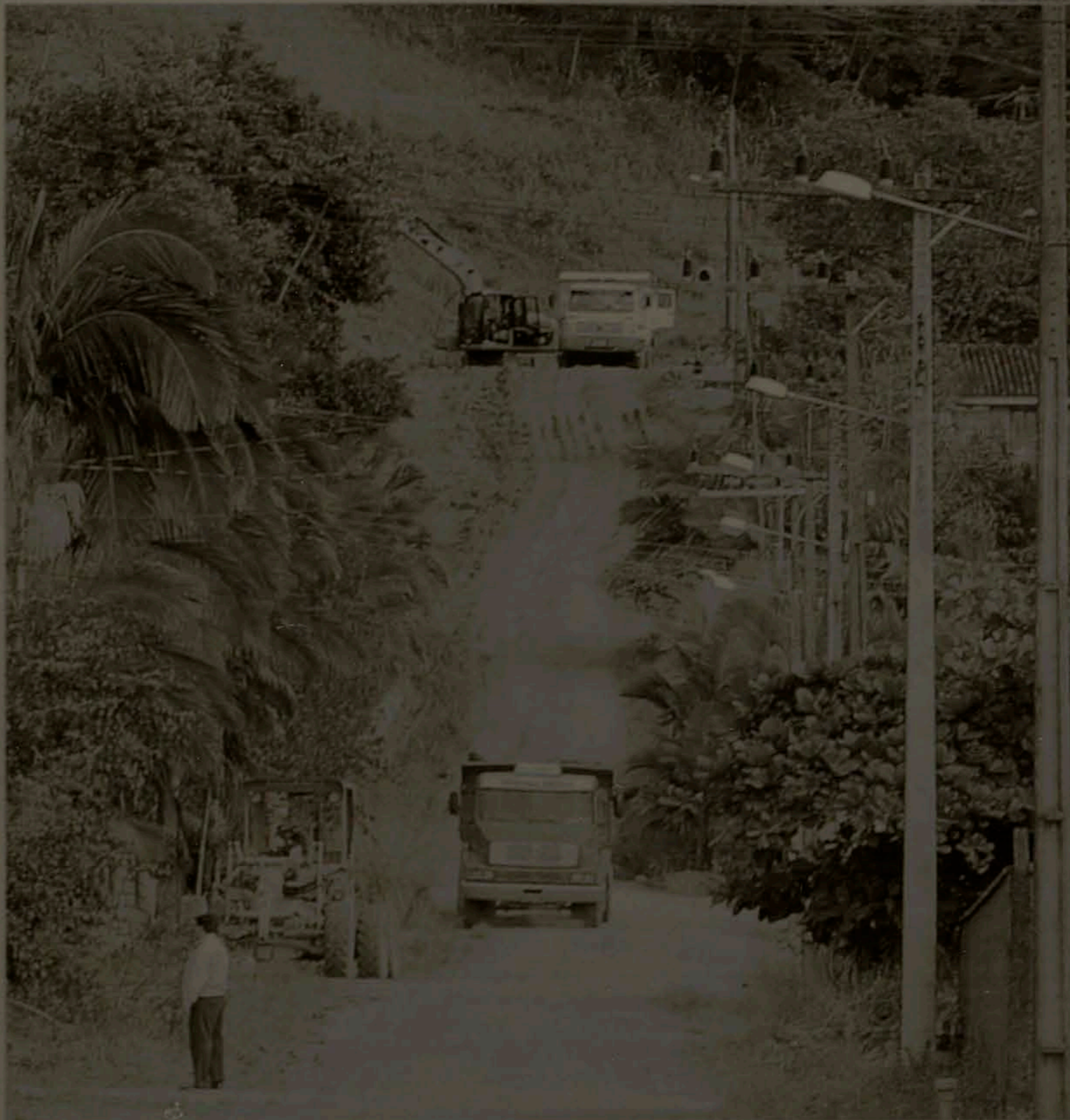
Encostas são recuperadas novamente no morro do final da rua Gustavo Otto Welk, na Tifa Hanemann
