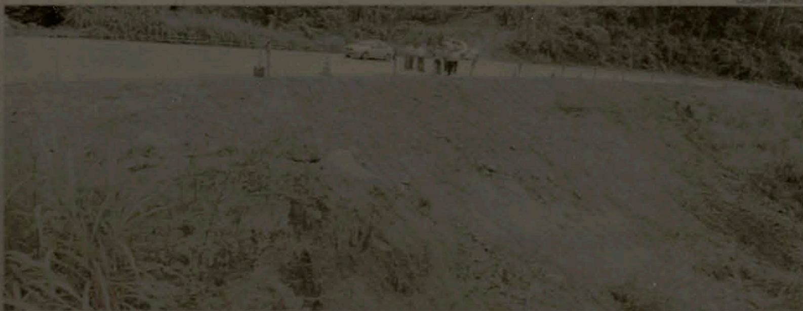
Chuva fez Dnit interromper as obras emergenciais na BR-280 - quilômetro 89 - de Corupá a São Bento do Sul
