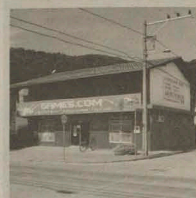
Ref. 1087 - Sobrado no Bairro Vila Nova, com: Piso inferior- sala comercial com 100,00m². Piso Superior- 1 suite, 3 quartos, bwc social, cozinha, churrasqueira, lavanderia, piscina, garagem. Preço RS530.000,00
