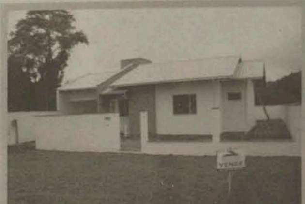
Ref. - 395 - BARRA DO RIO CERRO - casa alv. c/laje 80m², averbada terreno c/395,50m², 3qtos, sala, coz. a copa integradas, bwc, lavanderia, garagem, murada. Rua Vidal Maestri - Loteamento Residencial Trentino - R$ 175.000,00
