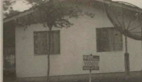
Cód 251 Jaraguá 84. Casa de alvenaria com 2 quartos, sala, cozinha, demais dep. RS60.000,000.
