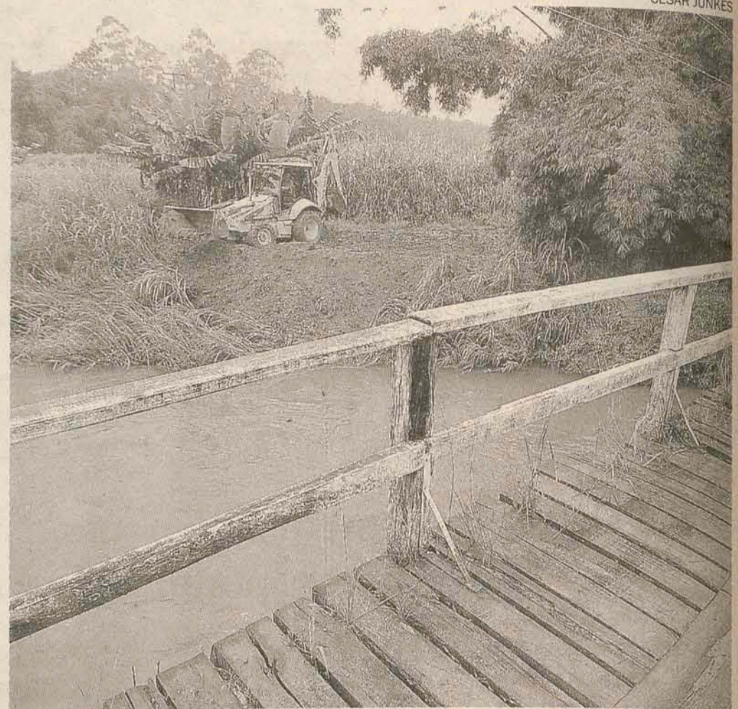
Mesmo com chuva, ponte de improviso começou a ser construída
