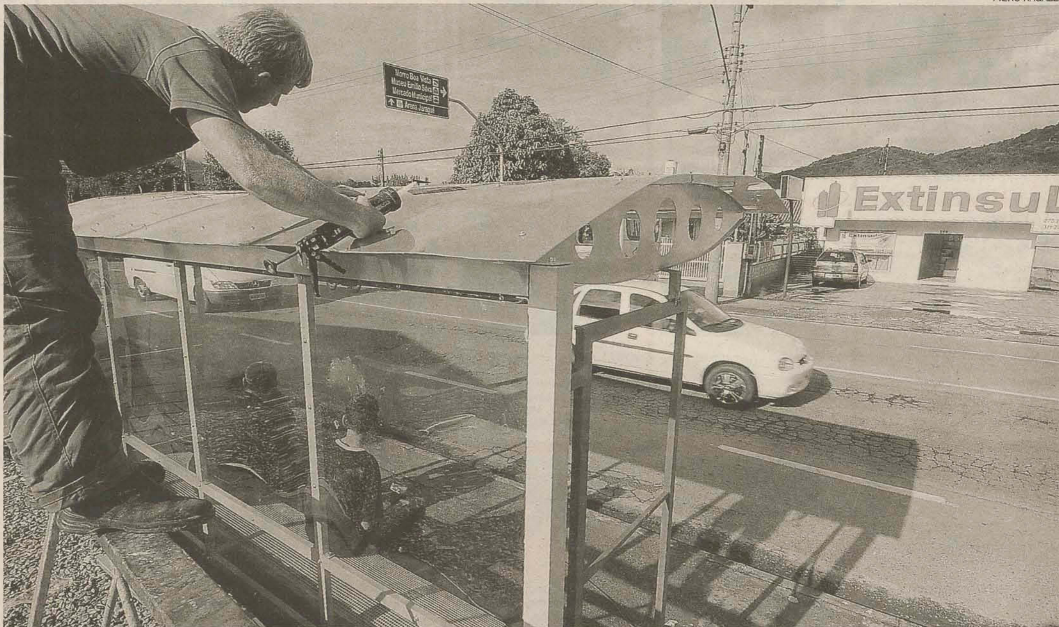
Ponto de parada de ônibus ainda depende de aprovação dos usuários para ser transformado em modelo padrão. Ele é feito de ferro e policarbonato
