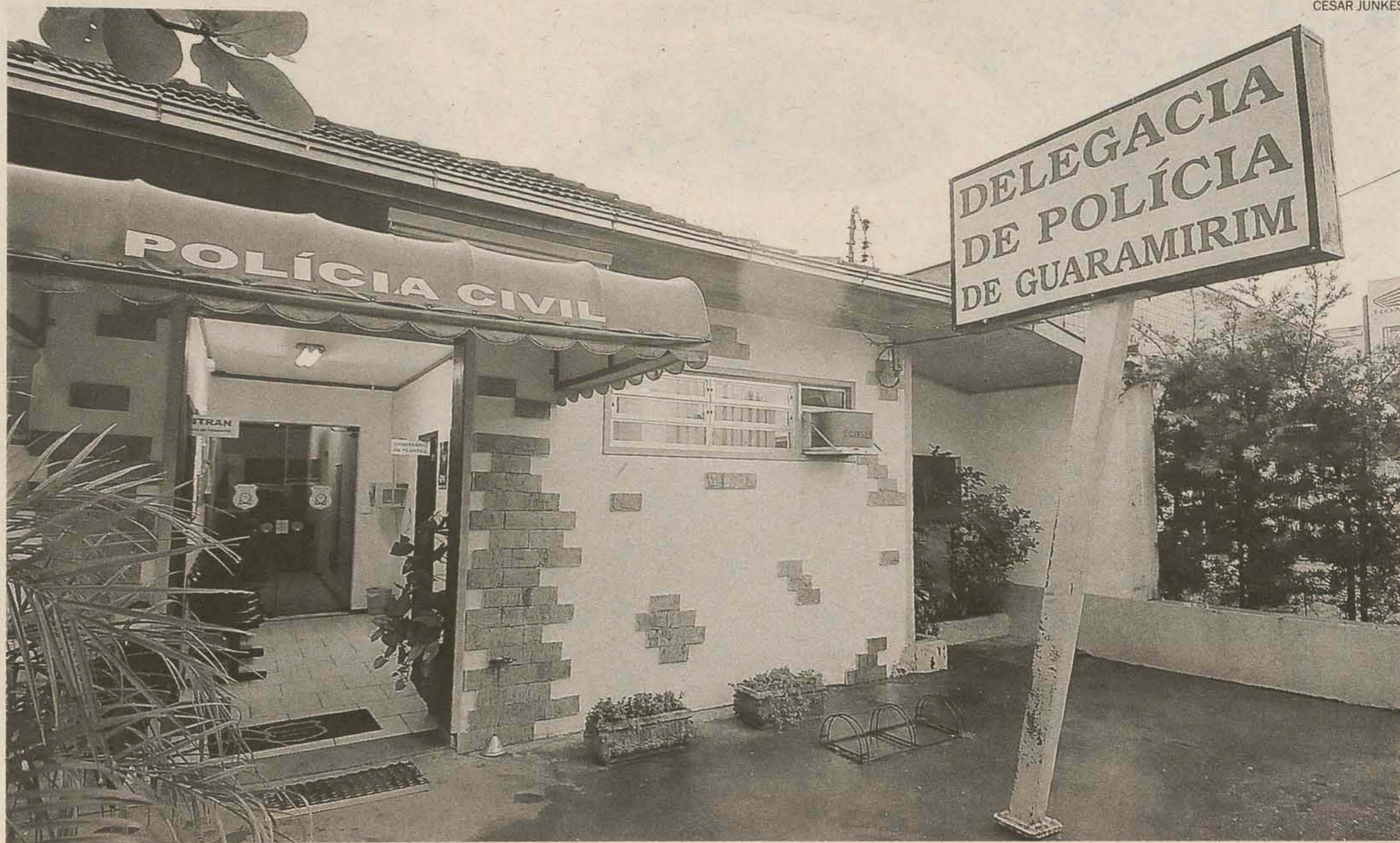
Atual sede da Polícia Civil de Guaramirim tem mais de 40 anos e apresenta vários problemas na estrutura, por causa da ação do tempo
