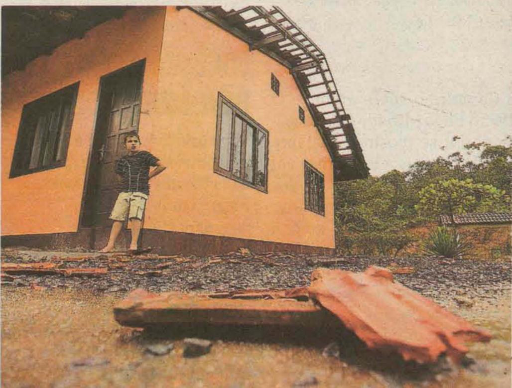
Casas no Santa Luzia ficaram destelhadas devido ao vento forte
