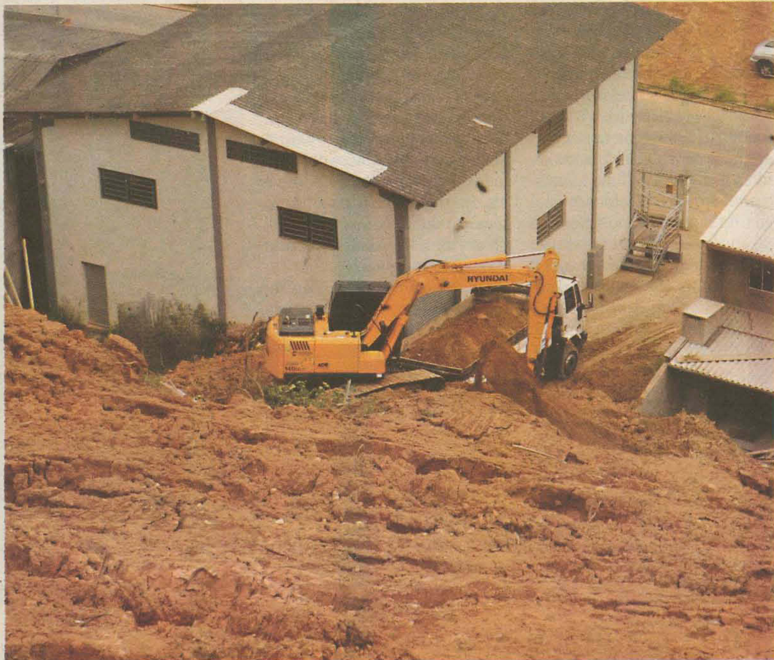
Na manhã de ontem, empresa de terraplanagem iniciou trabalho de remoção de barro nos fundos dos imóveis
