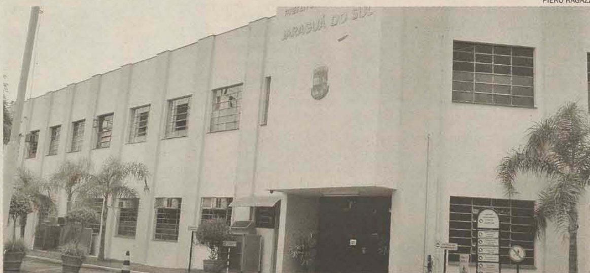
Parte dos setores públicos funcionarão em horário diferenciado durante as férias no Vale do Itapocu
