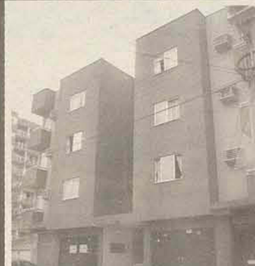
Ref. 1024 - Centro - Edif. Erica - apto 1 quarto, banheiro, sala, cozinha, lavanderia, garagem. R$90.000,00. Excelente localização. Aceita financiamento bancário.
