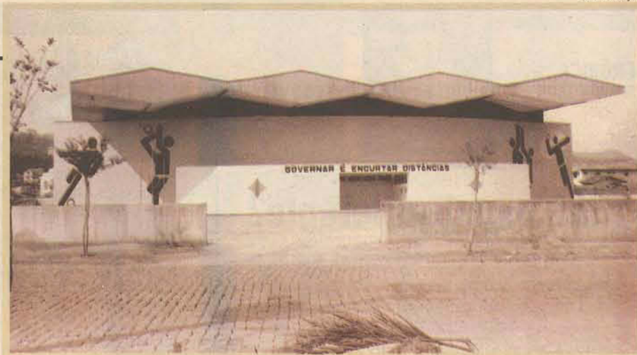
Ginásio recebeu verba do Estado para finalização das obras
