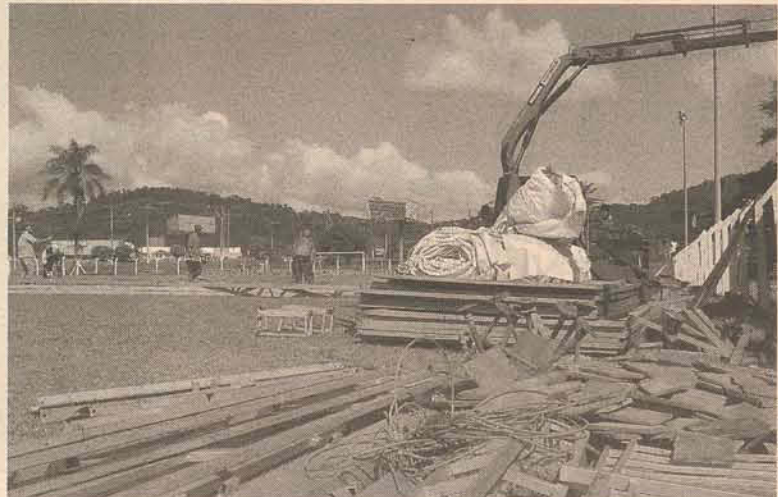
Estrutura já começou a ser montada para receber as comemorações
