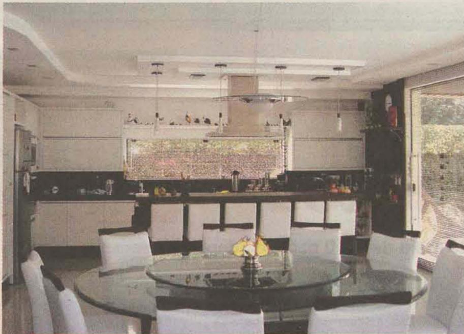
No teto, gesso produz efeitos com a sobreposição de molduras, além de sua utilidade tradicional de rebaixar o forro e embutir a iluminação. Material seca em pouco tempo, adquirindo sua forma definitiva em 8 a 12 minutos.
