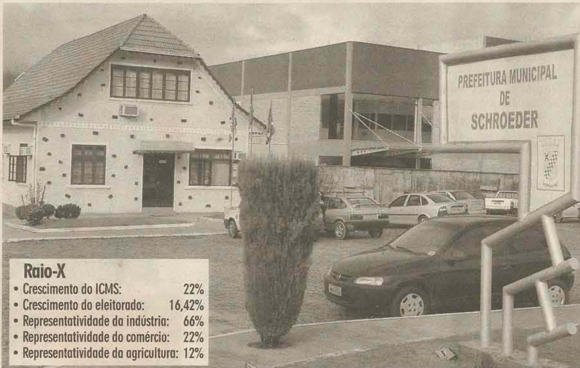
A construção do novo prédio administrativo, ao lado da atual Prefeitura, reflete o crescimento de Schroeder
