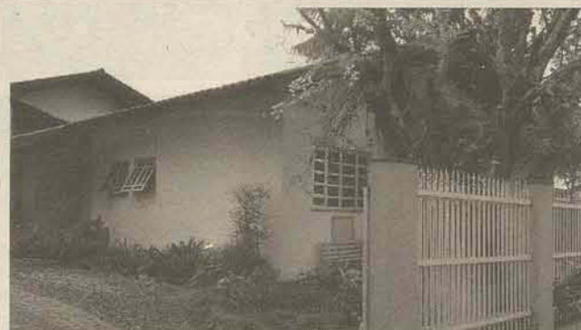
Casa Central - Próx. ao Restaurante Califórnia
