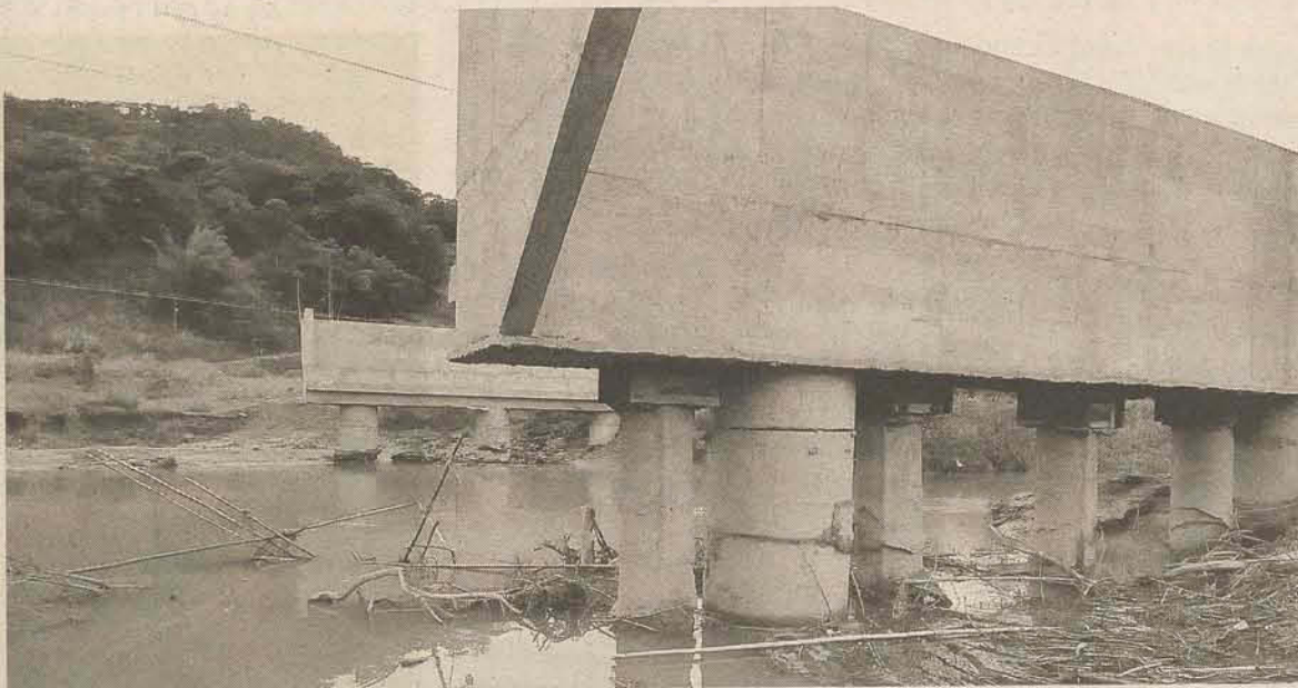
Em dez meses, somente os pilares e a cabeceira da ponte foram concluídos. Obra foi embargada em setembro
