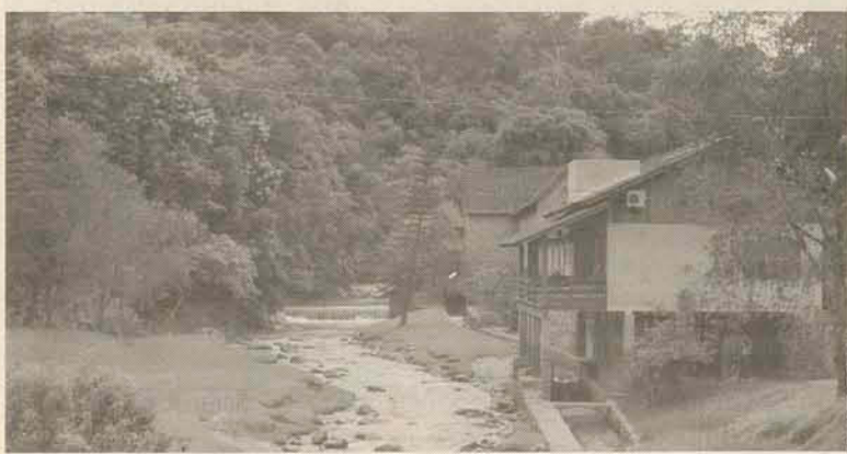
Problemas de erosão e sedimentos na água devem ser amenizados
