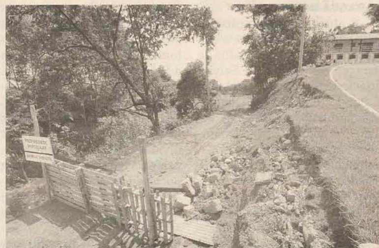
Obras no loteamento devem ser paralisadas pela Prefeitura
