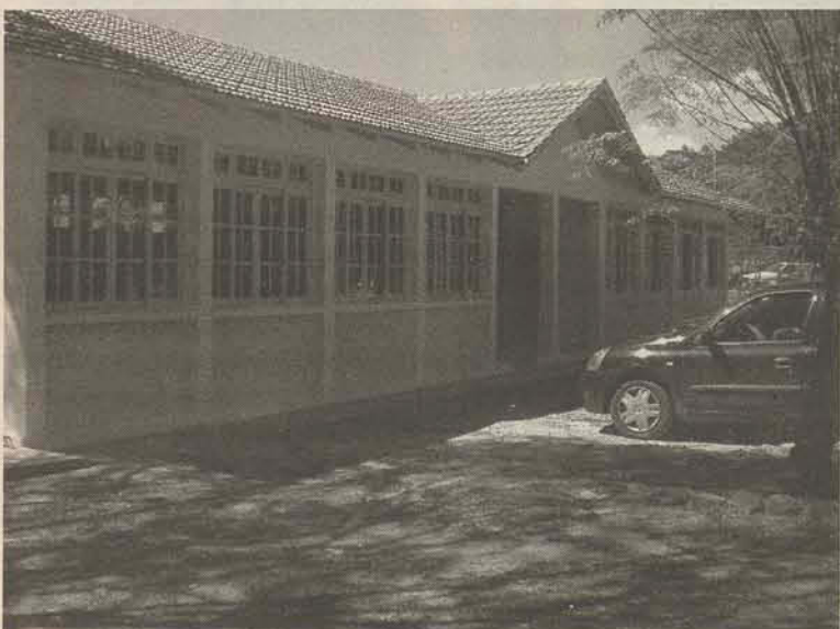
Obras de ampliação na antiga Escola Municipal José Pasqualini
