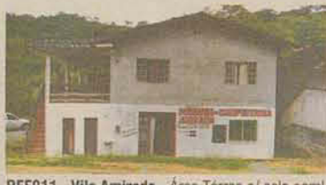
REF911 - Vila Amizade - Área Térrea c/ sala com 80m² c/ 2 bwc's, 2 qtos, lavanderia, garagem. Área Superior c/ 3 qtos, bwc, sala, cozinha, área de serviço, sacada. Área total de constr. - 260m². R$ 180.000,00.
