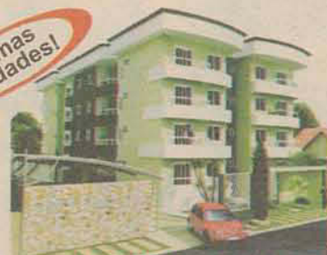
RESIDENCIAL SANTA CATARINA APARTAMENTOS COM SUÍTE + 2 DORMITÓRIOS E DEMAIS DEPENDÊNCIAS. OBRA EM FASE FINAL!
