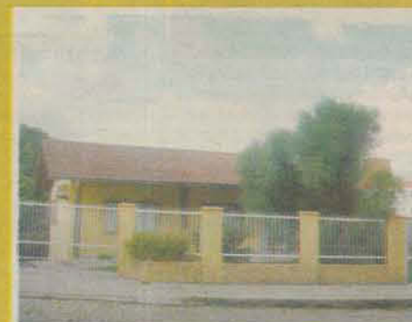
28.1 CASA EM ALVENARIA - JGUA ESQUEERDO - PRÓX. SPEED PNEUS
