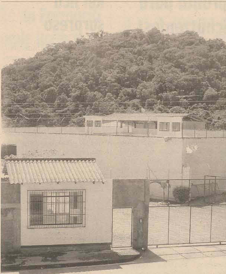
Ampliação do presídio também depende de regularização da área doada
