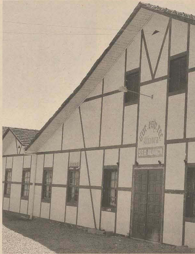
Sociedade Aliança, no Rio Cerro II, terá que passar por adequações
