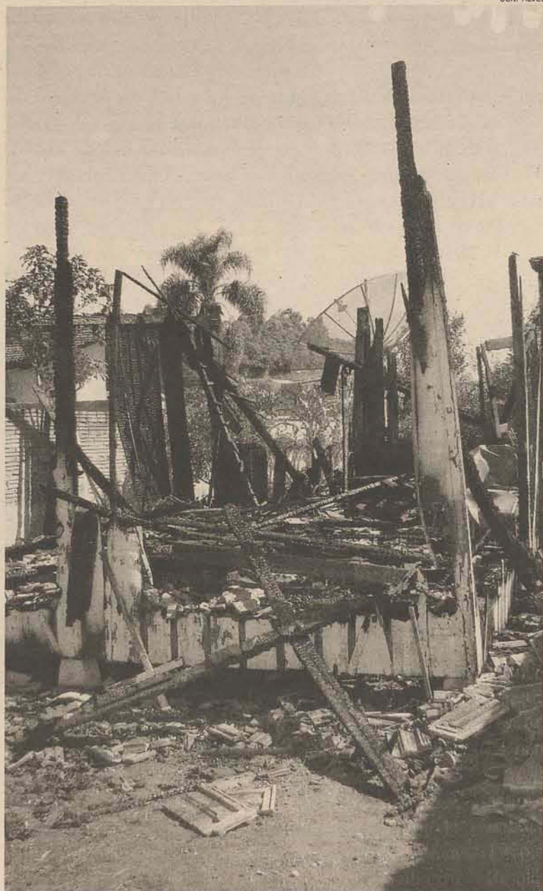
Fogo consumiu totalmente a residência de madeira no bairro Caixa D'Água
