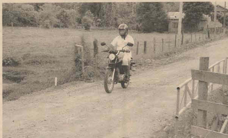
Secretaria de Obras promete vistoriar ponte sem proteção lateral e estreita
