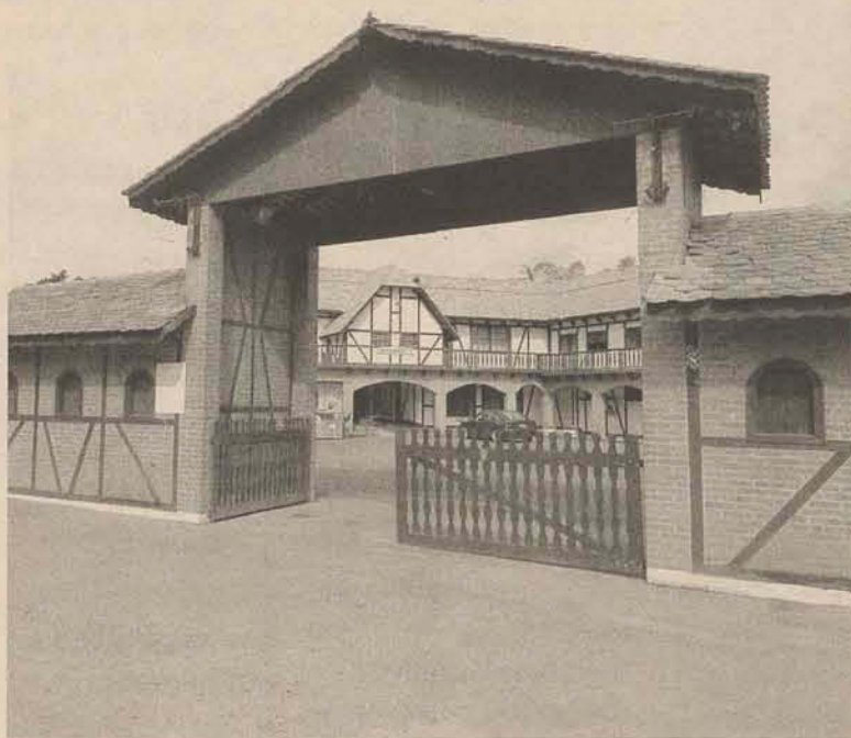
Porta aberta proporciona a entrada de qualquer pessoa, sem controle algum
