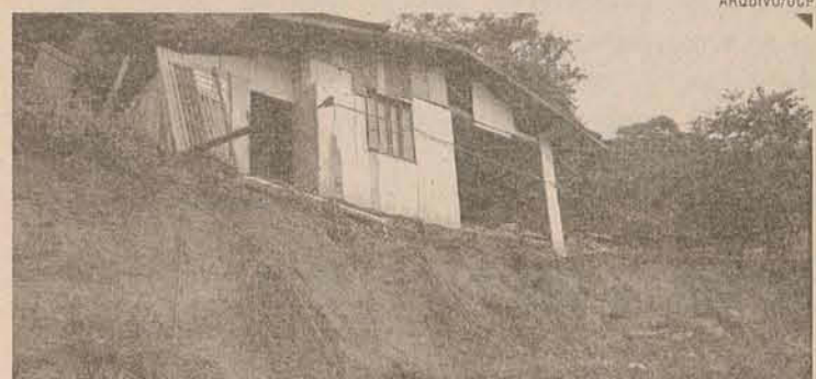
Município tem 50 casas em áreas de risco, ocasionando deslizamentos
