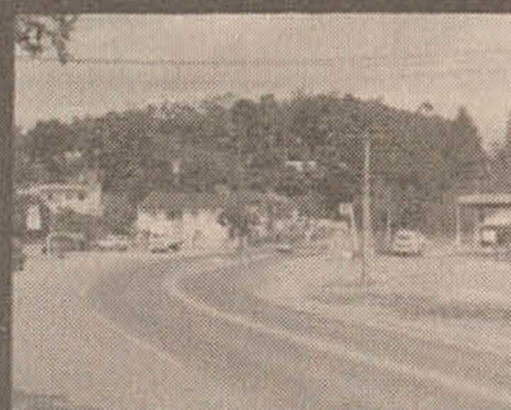
SC-418 Reabilitação Pomerode - BR-470 (em finalização)
