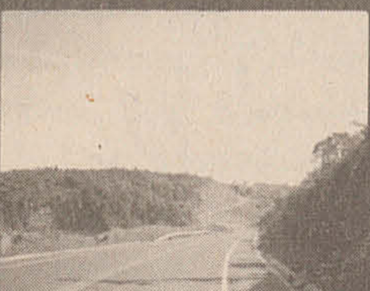
SC-469 Pavimentação Campo Erê - Saltinho - Serra Alta
