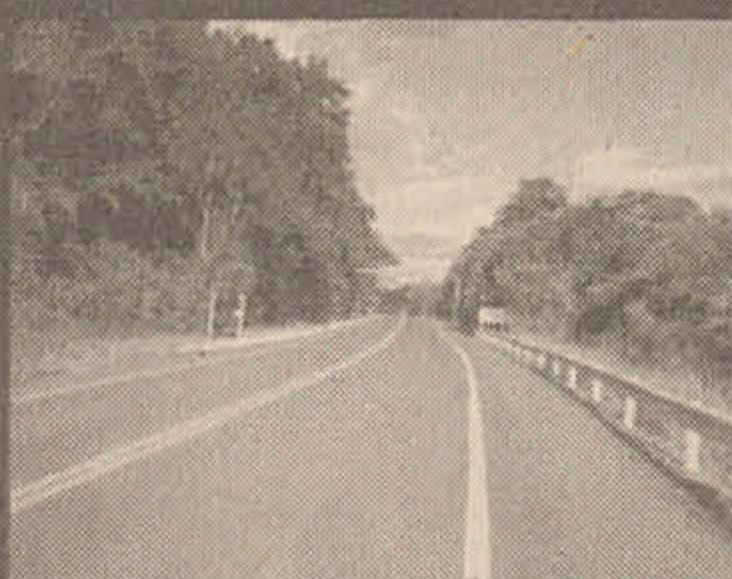
SC-466 Pavimentação Seara - Itá
