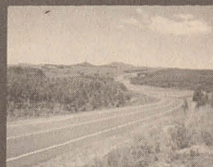
SC-427 Pavimentação Rio Rufino - BR-282
