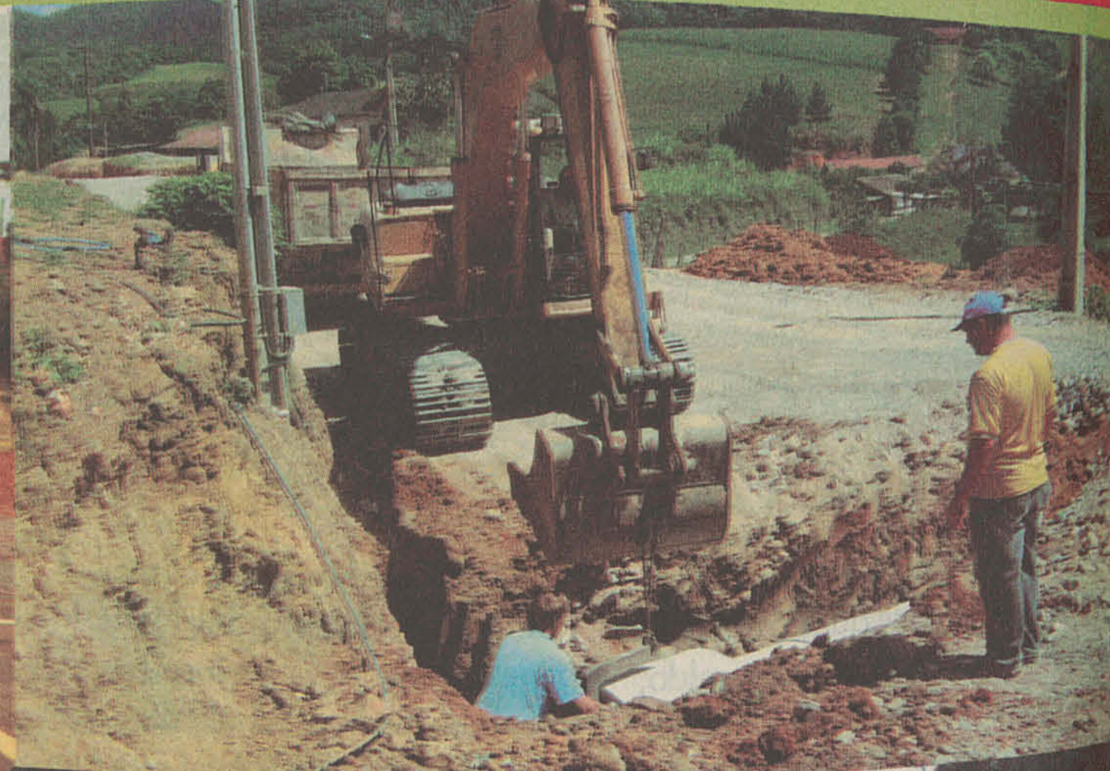
Pavimentação do acesso a José Boiteux (em andamento)
