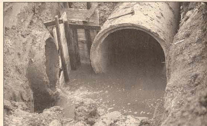
Todos de 60 cm de diâmetro estão sendo trocados por de 80cm
