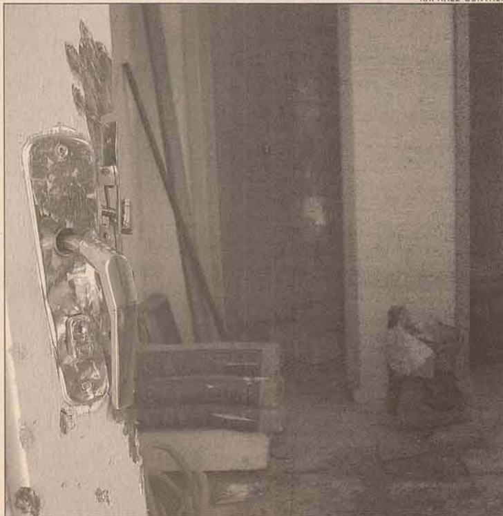
Obra, que teve investimento de R$ 700 mil, está abandonada
