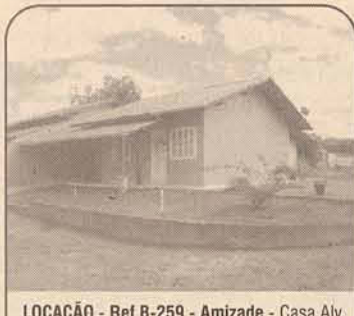
LOCAÇÃO - Ref B-259 - Amizade - Casa Alv. c/ 02 dorm - sala - cozinha c/ móveis sob medida - bwc - lavanderia - garagem - R: Paulo Klitzke,317. R$440,00
