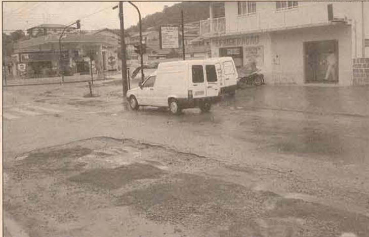
A Prefeitura já começou a fazer o trabalho de recuperação do asfalto
