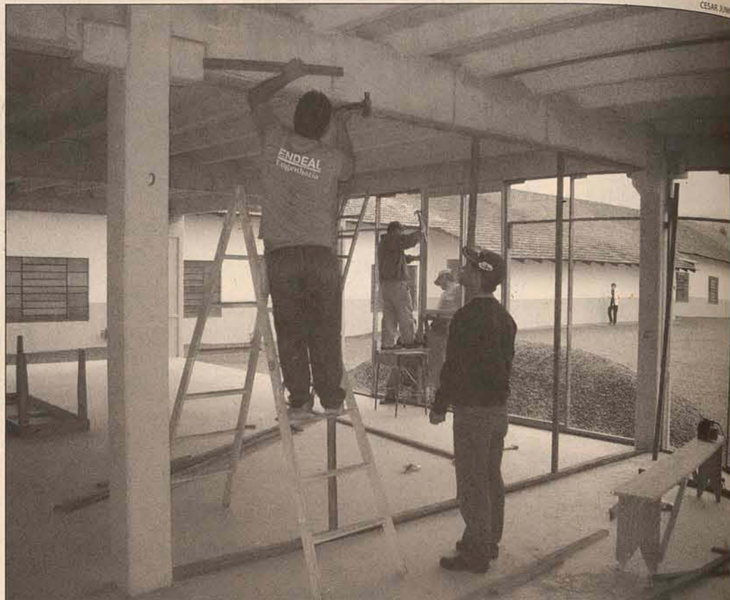
O galpão da Igreja Nossa Senhora Aparecida está sendo reformado para receber os alunos
