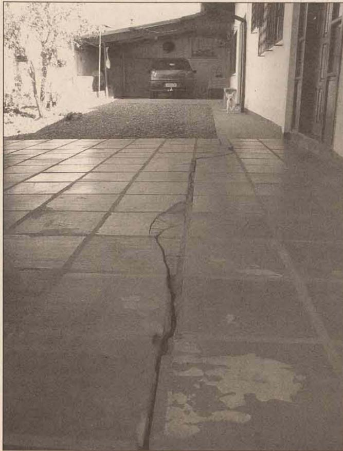
Segundo morador, rachadura na calçada foi causada pela trepidação
