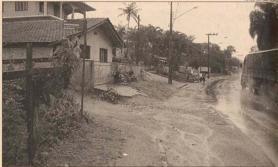
A rua foi asfaltada mas não ganhou drenagem, por isso todo o cascalho da rua de cima invade a pista
